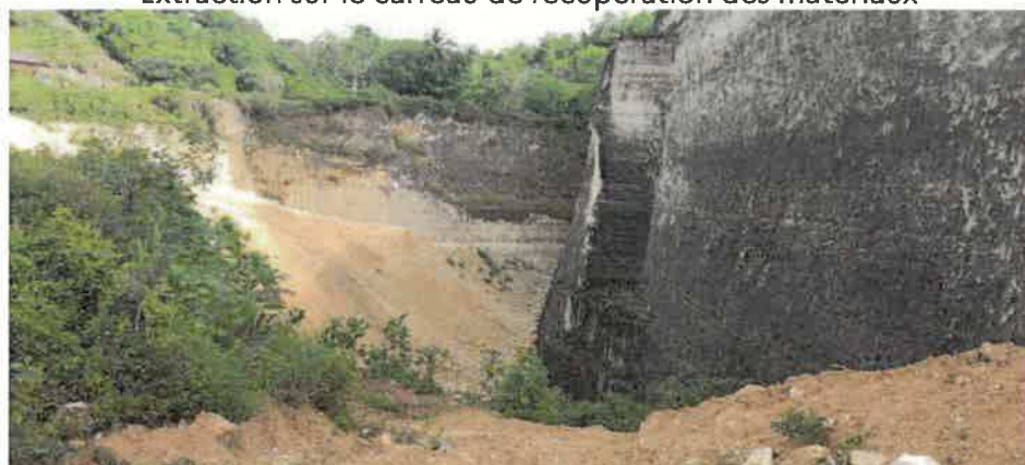
Extraction sur le carreau de récupération des matériaux
