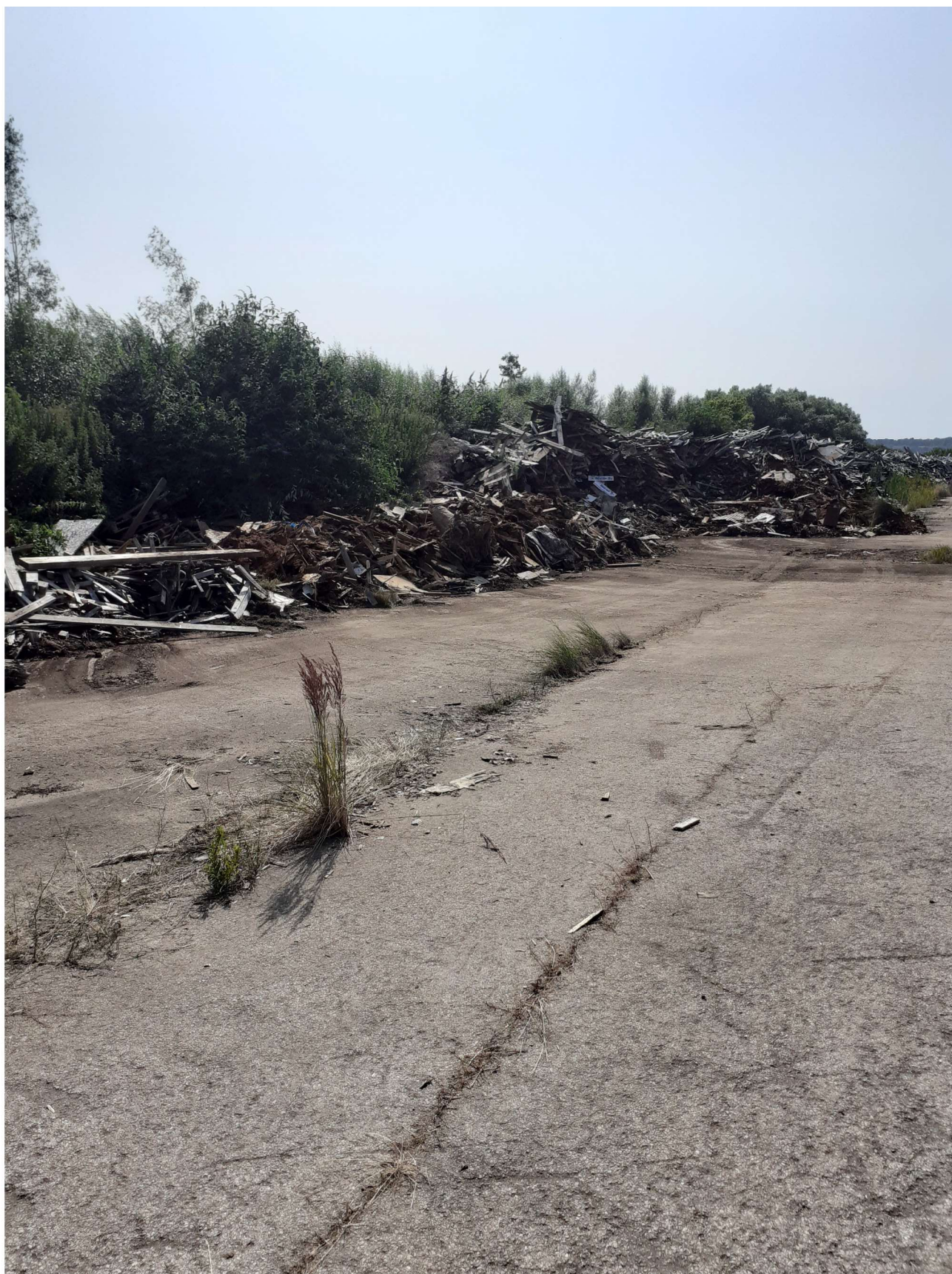
Évacuation d'une partie du tas de déchets présents le long de la limite sud
