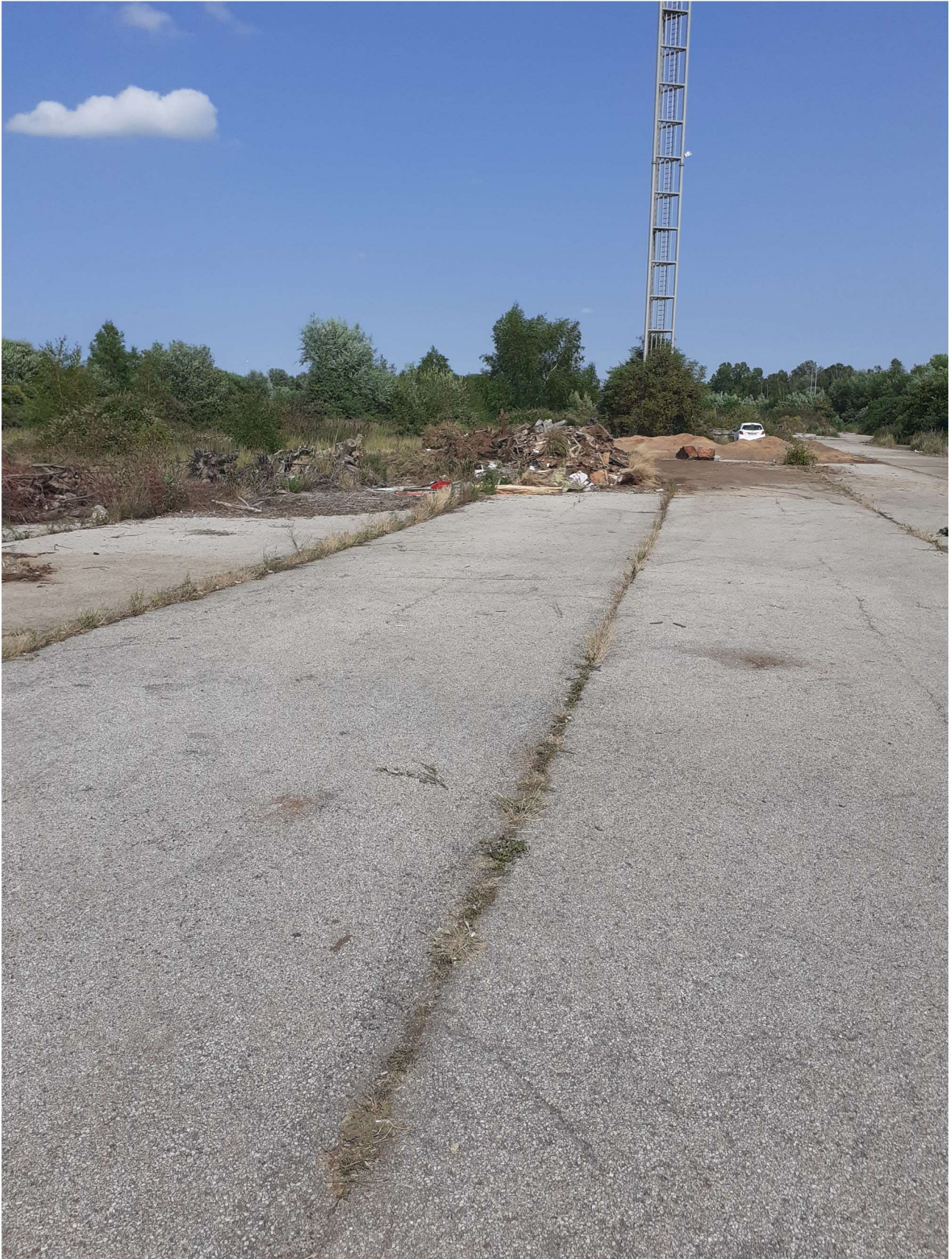
Premier tas de bois B brut situé à l'entrée du site évacué, la photo montre qu'il reste un petit tas de déchets n'ayant pas été enlevés car il ne s'agit pas de bois B Brut
