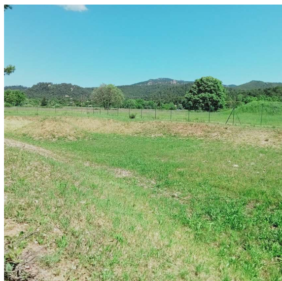
Bassin d'infiltration en sortie des eaux résiduaires du site
