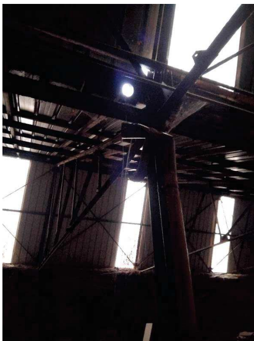
Figure 5 : Les toitures ne sont plus étanches
