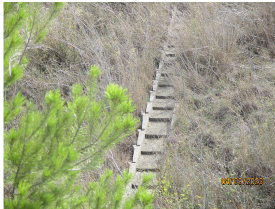
Cunette de collecte des eaux pluviales
