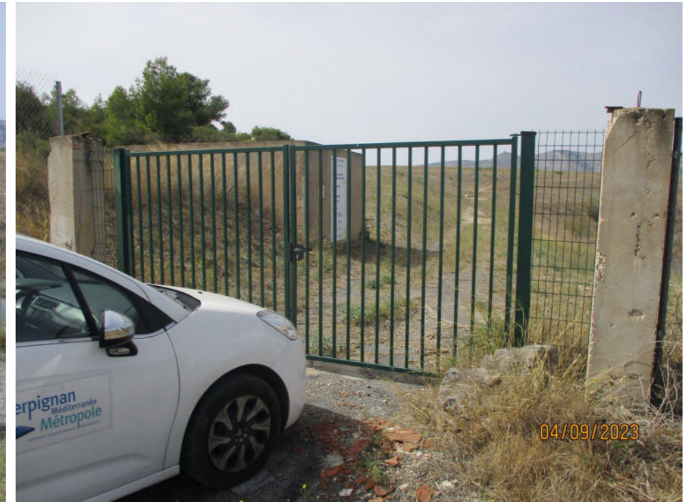
Portail fermant l'entrée principale du site
