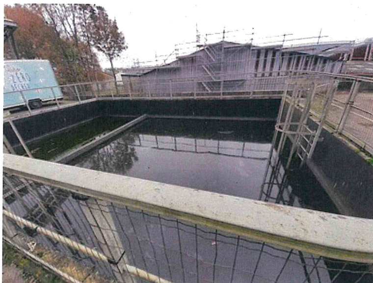
Bassin de confinement
