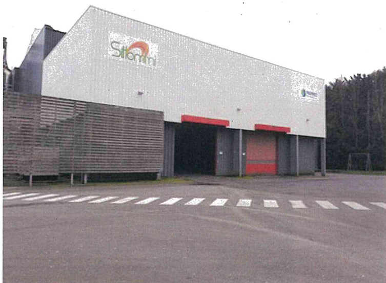
Hangar de réception des camions bennes transportant les déchets
