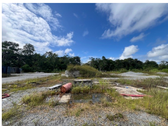
Plateforme abandonnée de la centrale d'enrobage
