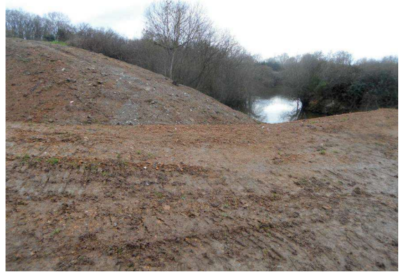
Vue depuis le nord
