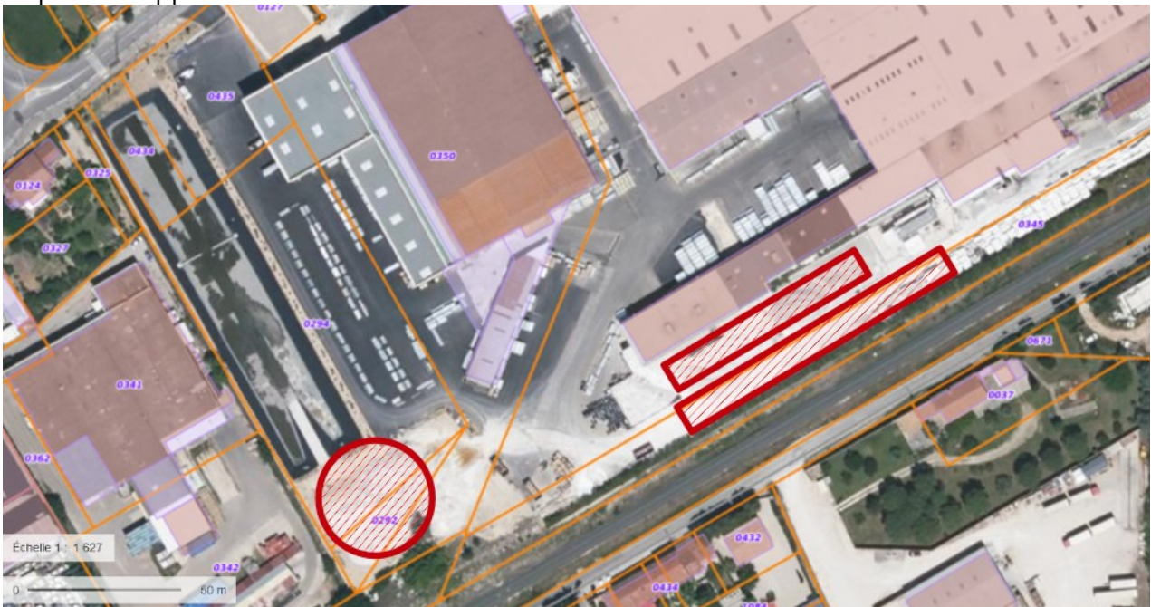
Zones d'entrepôts au sud ouest de l'usine
