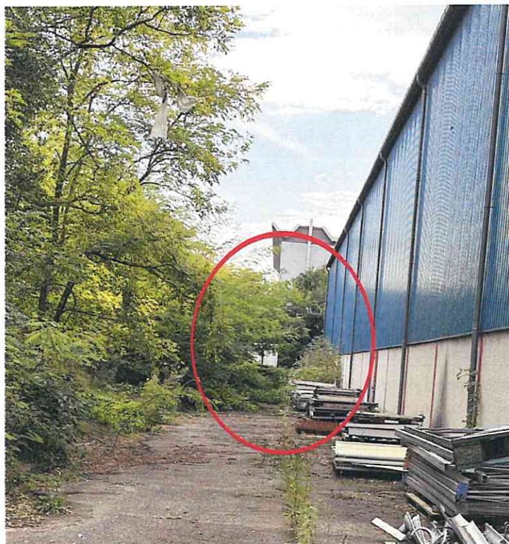
Encerclé en rouge : la végétation et la remorque à l'arrière du bâtiment
