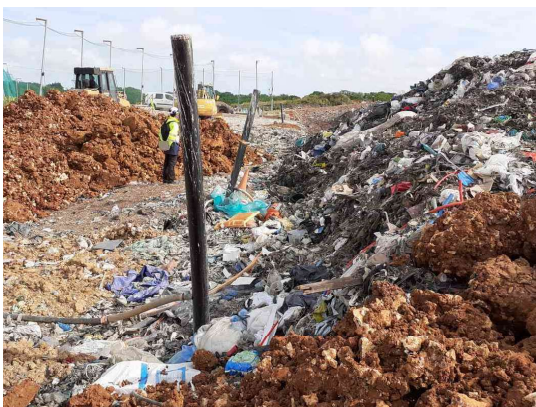
Illustration 4 : puits verticaux non étanchés à la base (photo de l'inspection)
