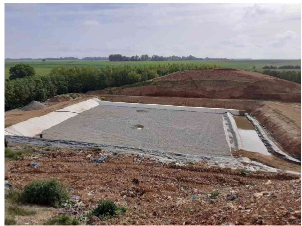
Illustration 7 : casier 4.7 en cours de préparation pour une exploitation prochaine
