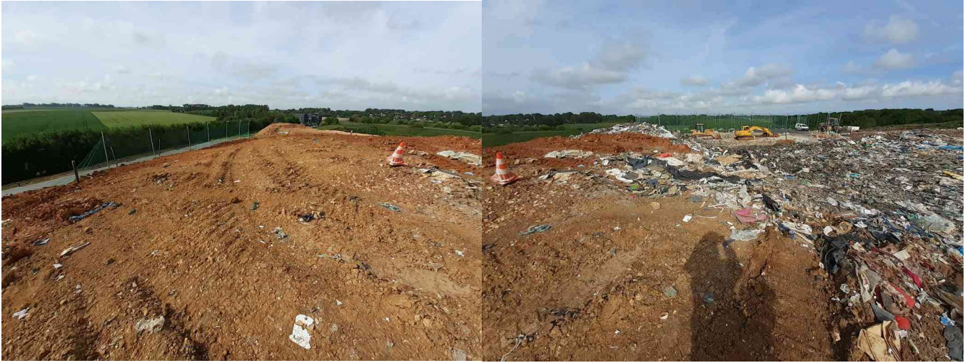
Illustration 5 : Vue d'ensemble du casier 4.5 avec une couverture provisoire sur environ un tiers de sa surface en partie sud
