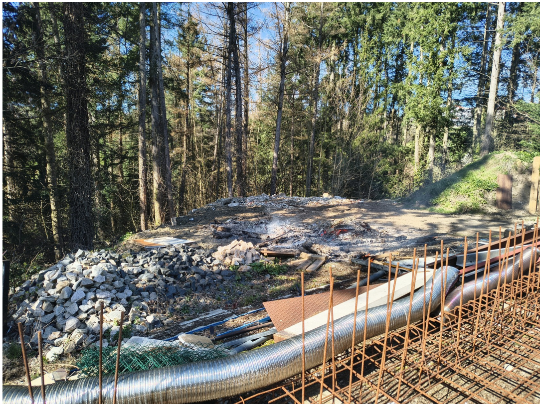
vue d'ensemble de la plateforme en remblai
