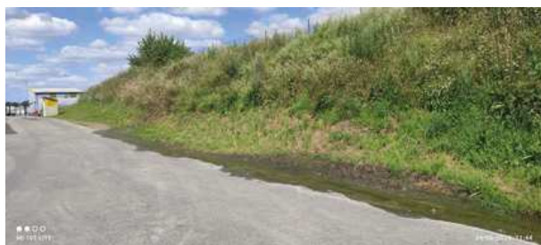
Fuite de la digue de la lagune de stockage des effluents liquides vers un regard des extérieurs du site.
