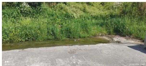
Fuite de la digue de la lagune de stockage des effluents liquides vers un regard des extérieurs du site.
