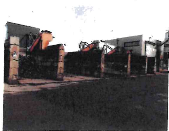
Cellule d'entreposage des déchets triés en sortie du QZ
