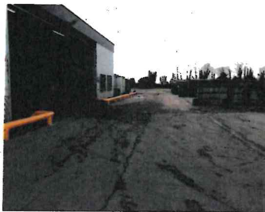
Voies de circulation enrobées
