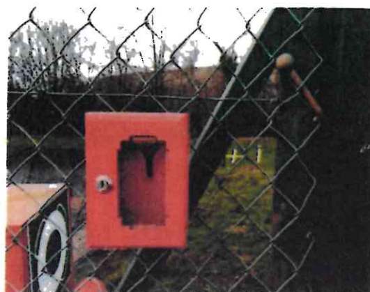
Boîte à clé et marteau (non signalé), au portillon d'accès à l'enclos du bassin
