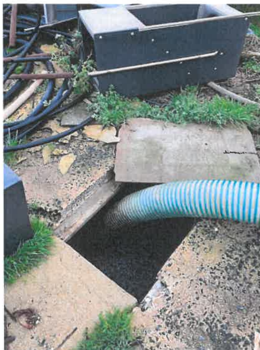
Autres déchets et matériaux divers recouvrant la dalle de la fosse à lisier Sto3
