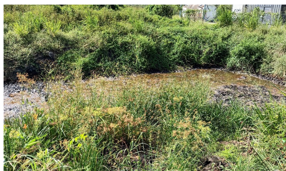
Bassin de traitement des terres polluées
