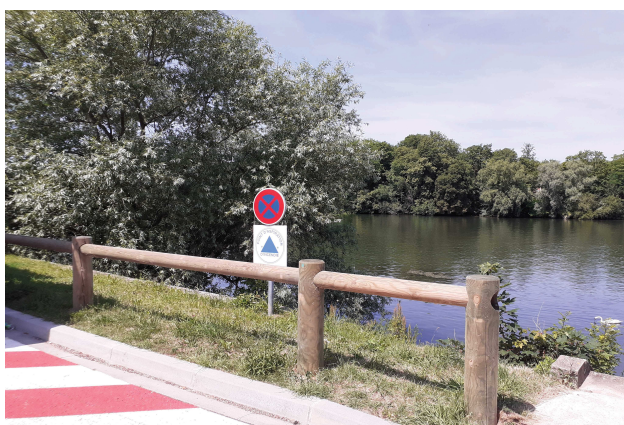
Point d'aspiration incendie – quai du port au vin face à l'établissement
