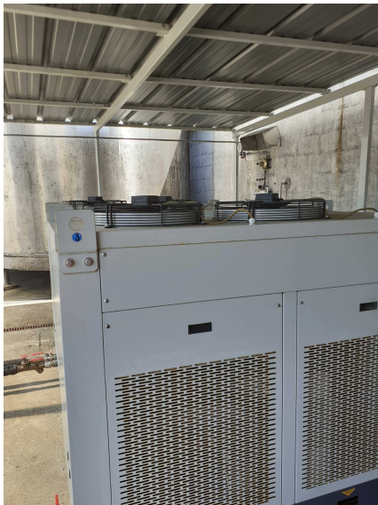
Compresseur CUVE 1 (R410A)
