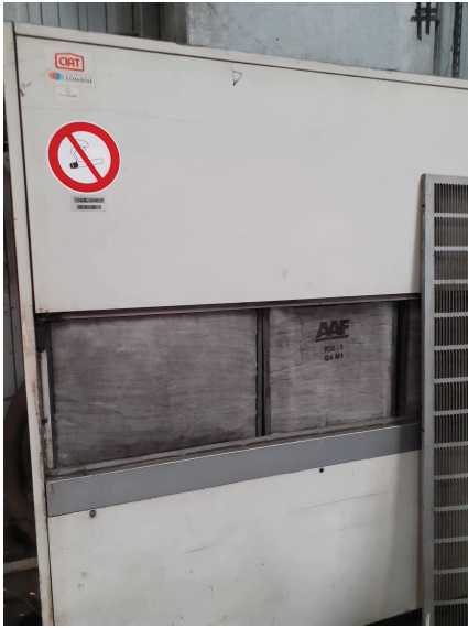
Climatiseur hors service local export (fluide R22) Climatiseur hors service local export (fluide R22) – détail vignette de marquage de contrôle d’étanchéité
