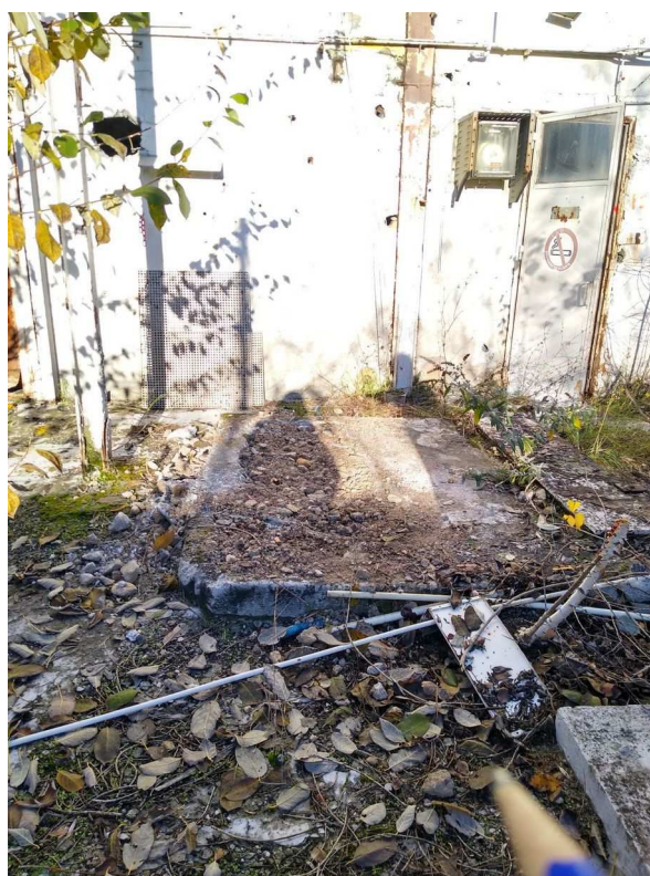
Fosse à lait de chaux comblée
