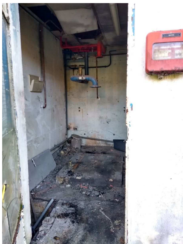
Emplacement de l'ancienne chaudière
