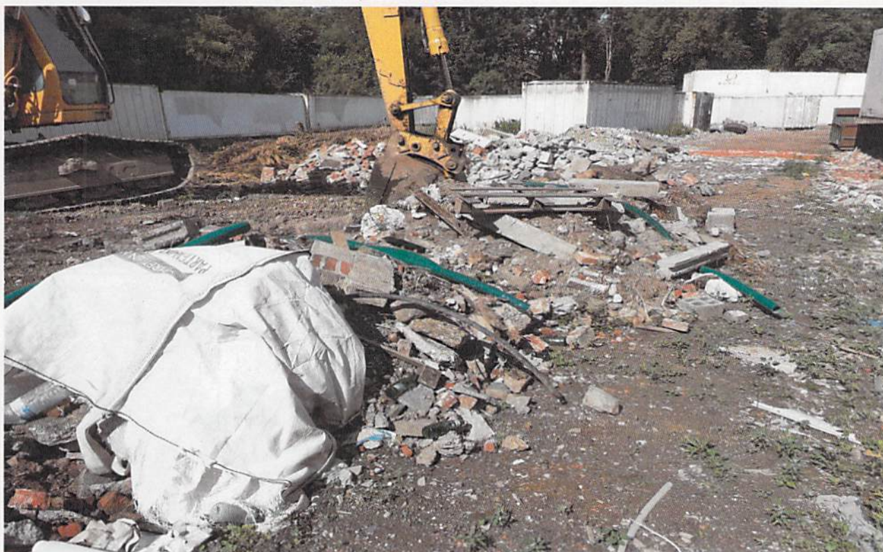
Opérations de terrassement en cours en partie arrière du site à partir de déchets de chantier non triés correctement à la source
