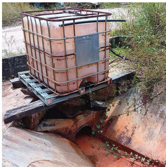
Traitement par floculation
