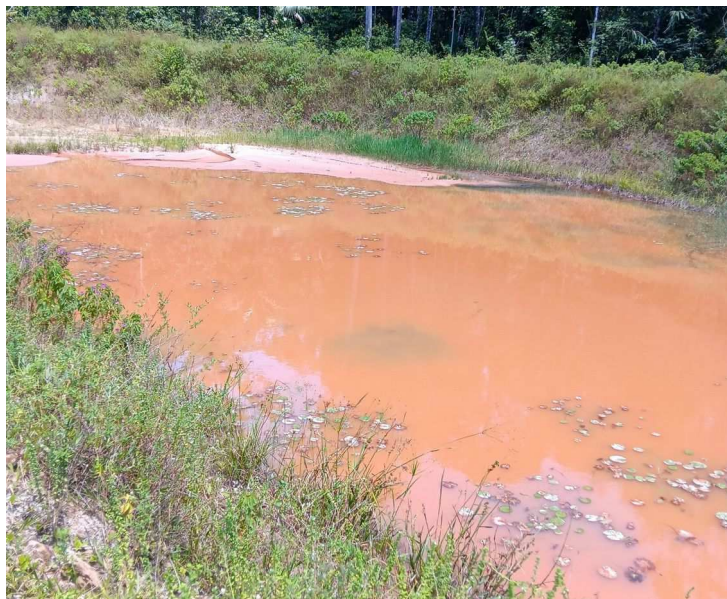
bassin de décantation entrée
