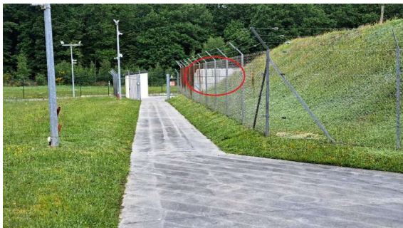
Cellule A1 depuis aire de livraison
