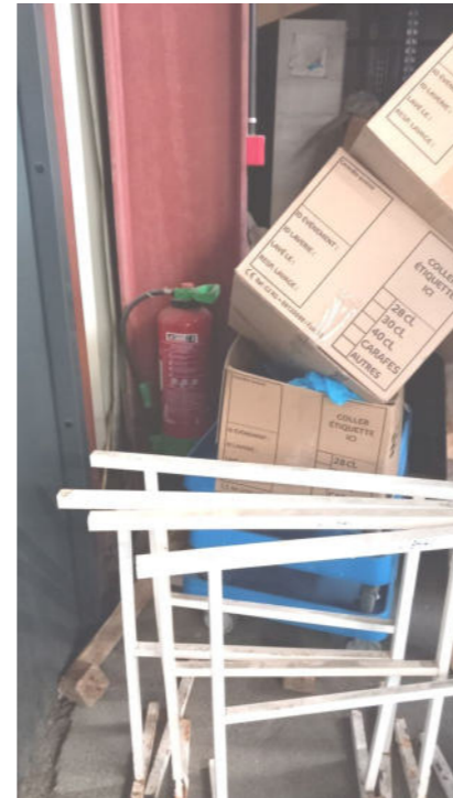
Accès à un extincteur, à une sortie de secours et à un dispositif intervenant dans la sécurité incendie entravé voire inaccessible
