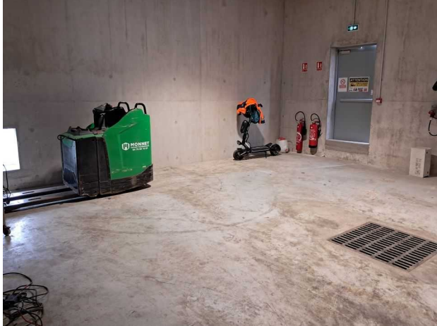
Ouverture Nord de ventilation de la zone de charge à moins 40 cm de haut
