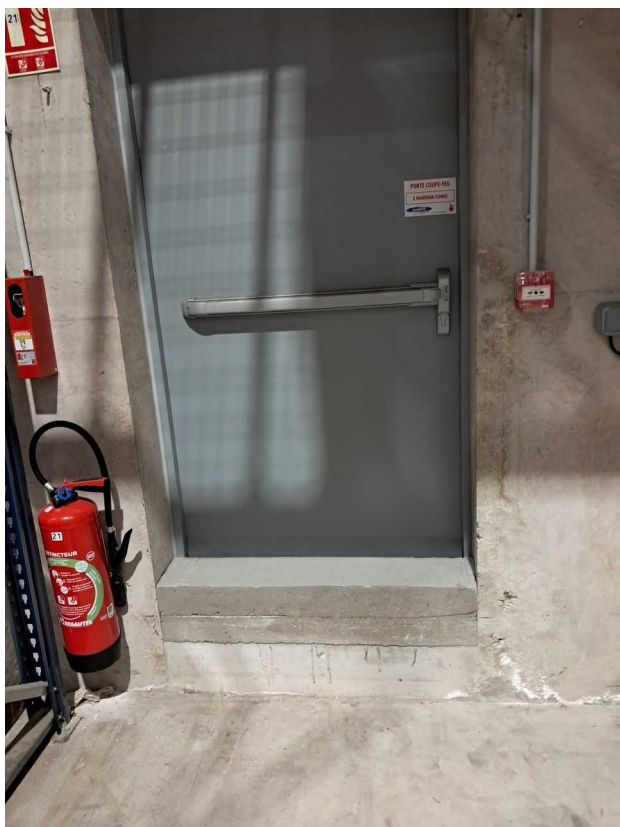
Rehausse béton devant l'issue de secours Nord-
