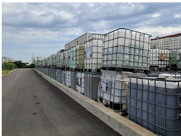
Zone de stockage extérieure Nord-Ouest de produits chimiques
