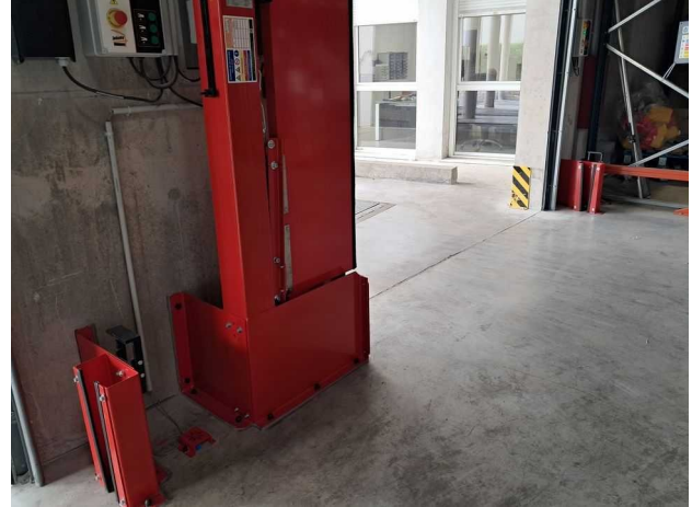
Nouveaux batardeaux mis en place devant les portes de quais
