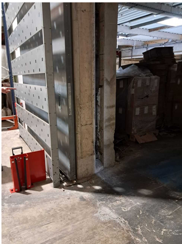
Batardeau non achevé devant la porte communiquant entre le bâtiment principal et le bâtiment « produits finis »
