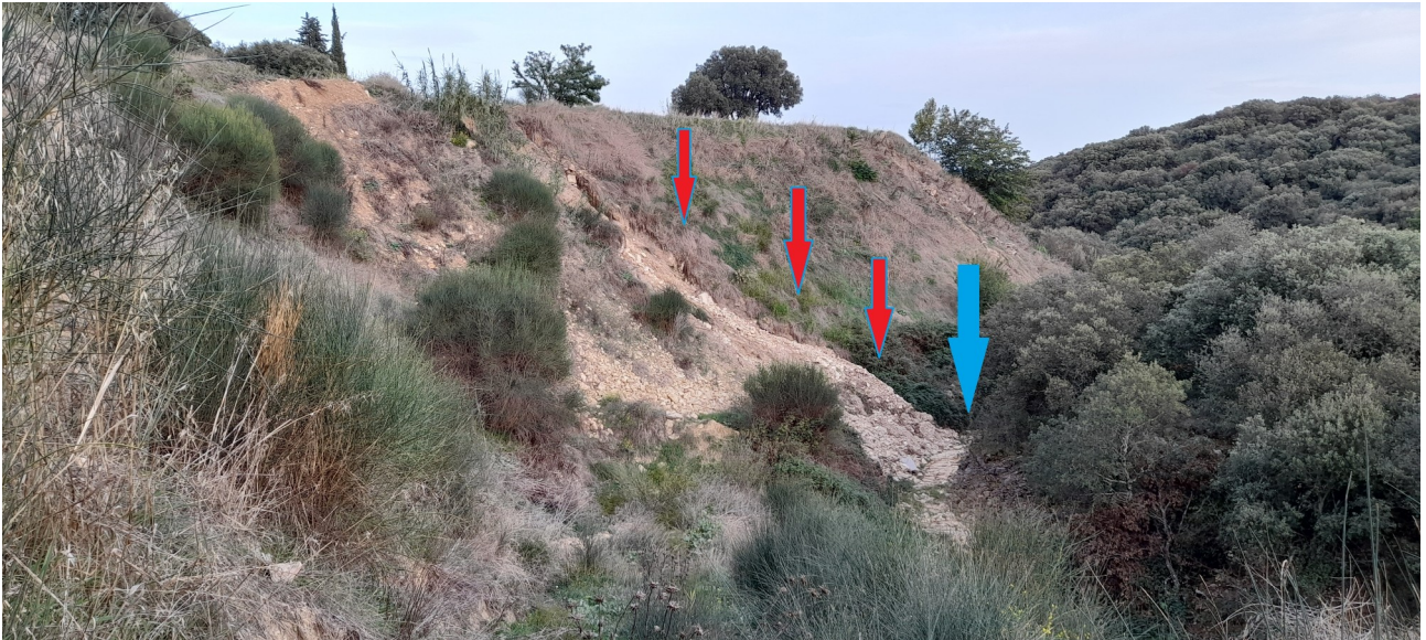
Figure 4: Glissement de matériau (en rouge) Lit asséché du ruisseau (en bleu) ; Vue sur le côté du talus
