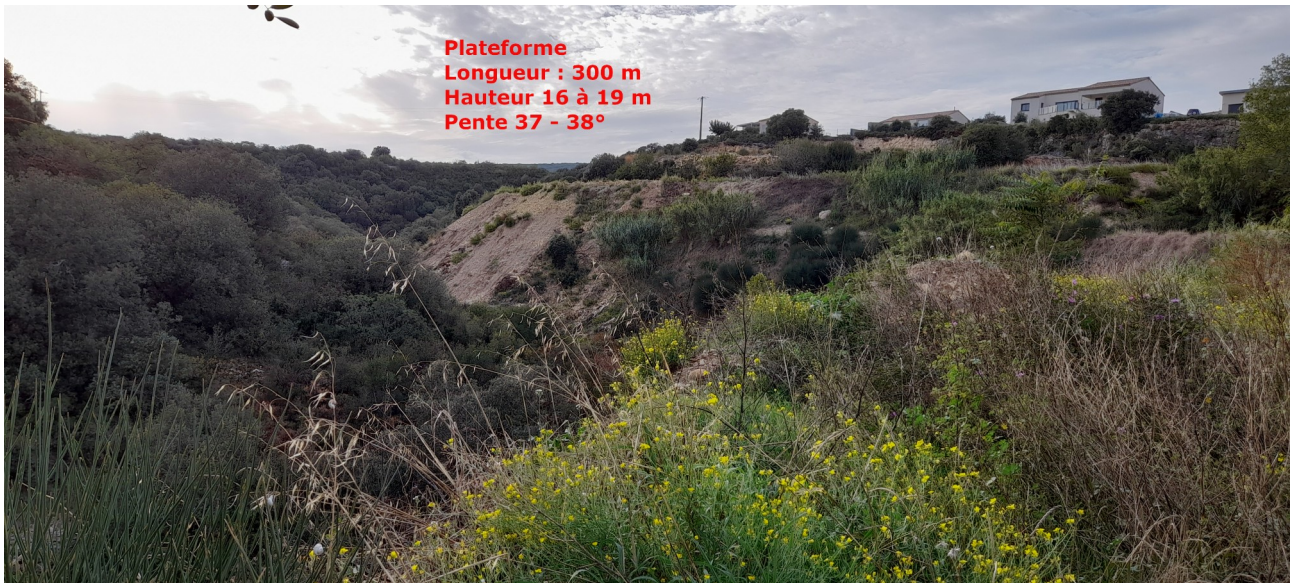
Figure 2: Plateforme de l'ISDI vue côté route départementale D4
