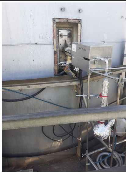
Pose de la canne de prélèvement dans la cheminée du four N° 1. Les dioxines sont stockées dans une matrice au carbone en sortie de la colonne à distillation (emballée dans le papier d'aluminium)
