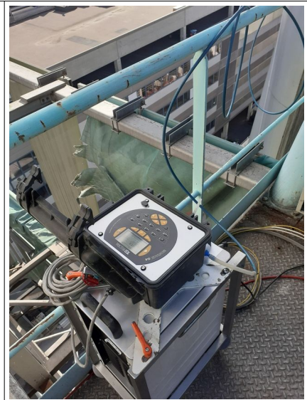
Dispositif de régulation du débit afin de maintenir l'isocinétisme avec le débit sortant de la cheminée du four n° 1
