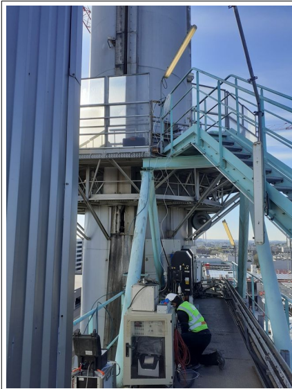
Installation des équipements au niveau de la cheminée du four N° 1
