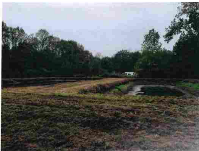
Lagunes de traitement des eaux usées
