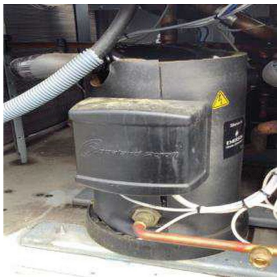
Compresseur du 3 e type de groupe froid
