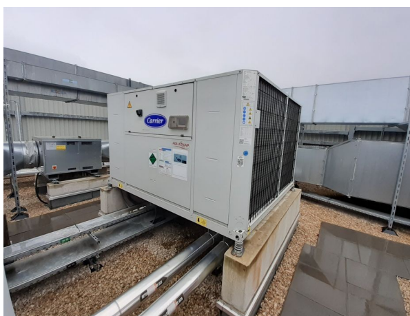
3 e type d'installation de groupe froid
