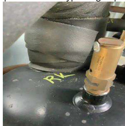
Compresseur du 2 e type de groupe froid
