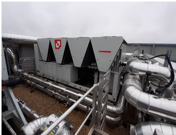
2 e type d'installation de groupe froid
