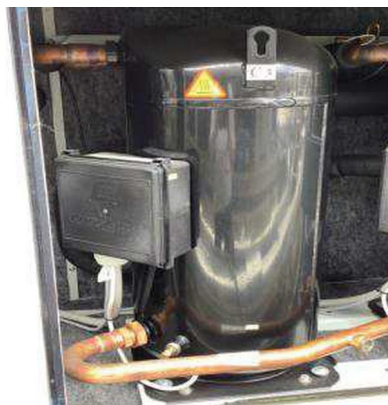
Compresseur du 2 e type de groupe froid
