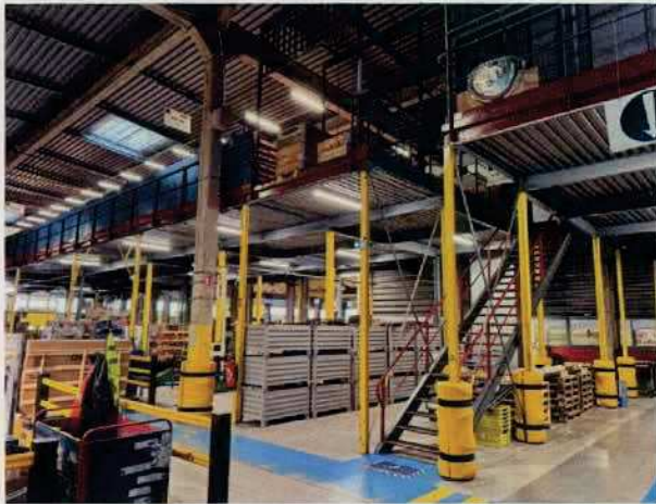
Mezzanine n°1 avec niveau plein
