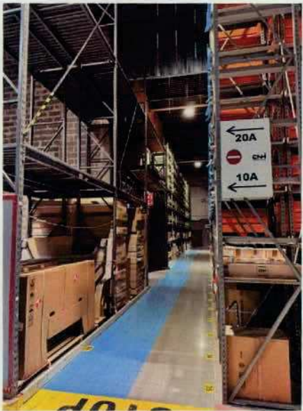
Stockage en racks dans le bâtiment principal
