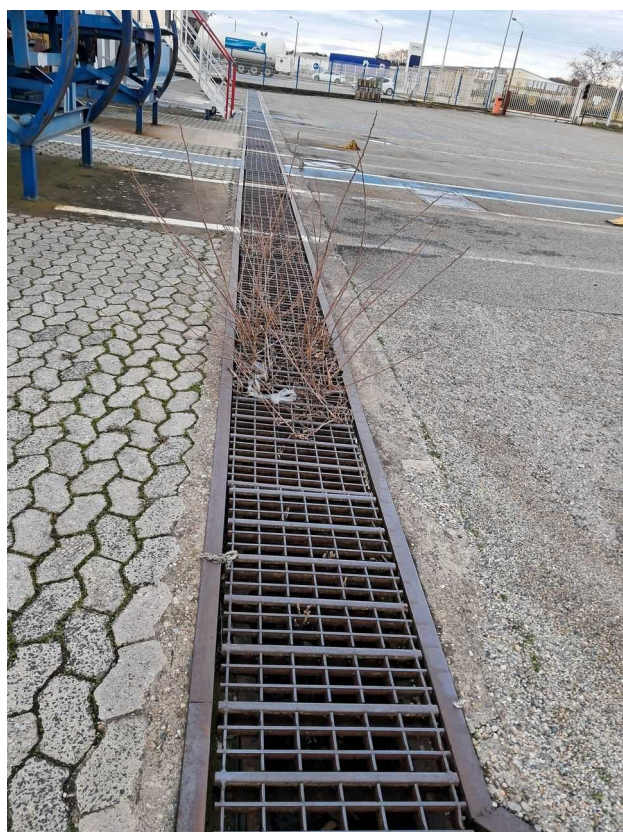
Grand avaloir de la zone Sud-Est (quais de chargement entrepôt)
