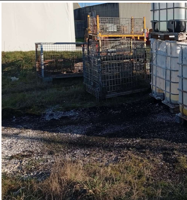
Traces blanches, témoin des déversements de chaux (produits dangereux et corrosif) sr un sol laissé nu (2/2)
