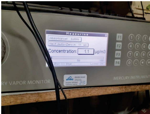
Affichage du mesureur en continu de Hg au rejet canalisé
