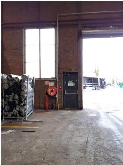
Photo 5 : issue de secours réparée et signalisée
