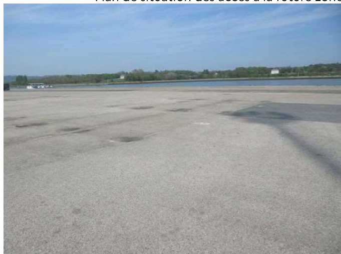
Futur emplacement de la zone de stockage de métaux (rubrique n° 2713)
