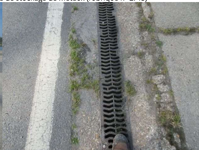
Caniveau existant de collecte des eaux pluviales ruisselant sur le site
