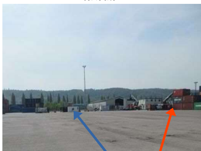
Vue sur les voies d'accès (entrée/sortie – voie pompier) envisagées depuis la zone de stockage
