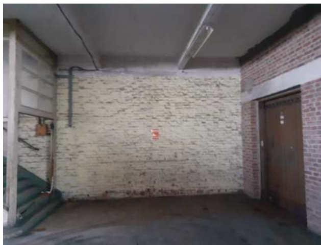
Espace sans stockage – mur mitoyen B0
