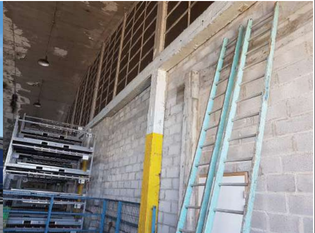
Photo 2 : paroi séparative B8-B9
