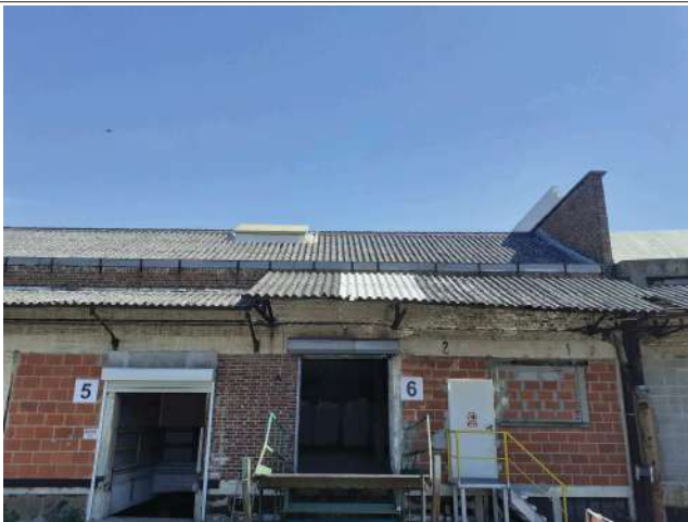
Photo 1: élévation du mur en toiture
