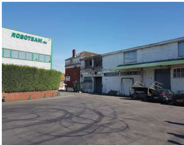
Mur mitoyen du B0
