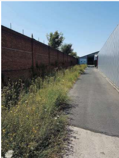
Photo 5 : derrière le bâtiment B3
