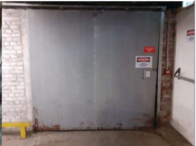
Photo 12 : portes coupe-feu entre sous-sol B1 et B2
