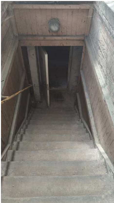
Photo 13 : escalier en bois accès sous-sol
