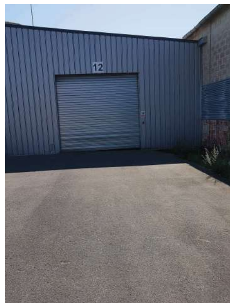
Photo 6 : Hangar métallique entre B4 et B5 pour parking couvert
