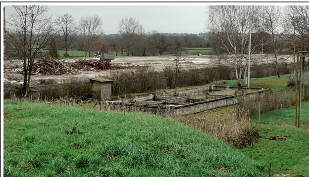
Bassins en contre-bas
