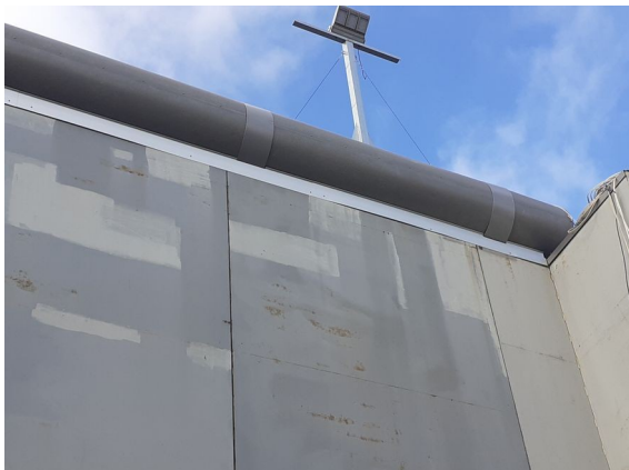
Couronnement du mur vue de l'intérieur du site
