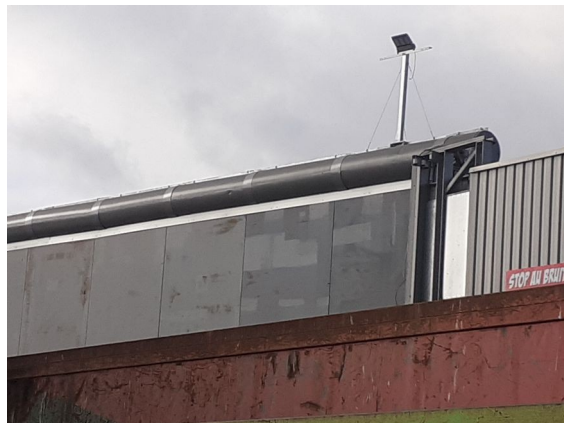
Couronnement du mur vue entre le passage de LUSOFER ver ELECTRO METAL SUD
