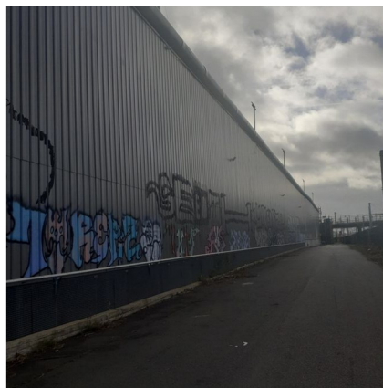
Couronnement du mur vue de l'extérieur du site
