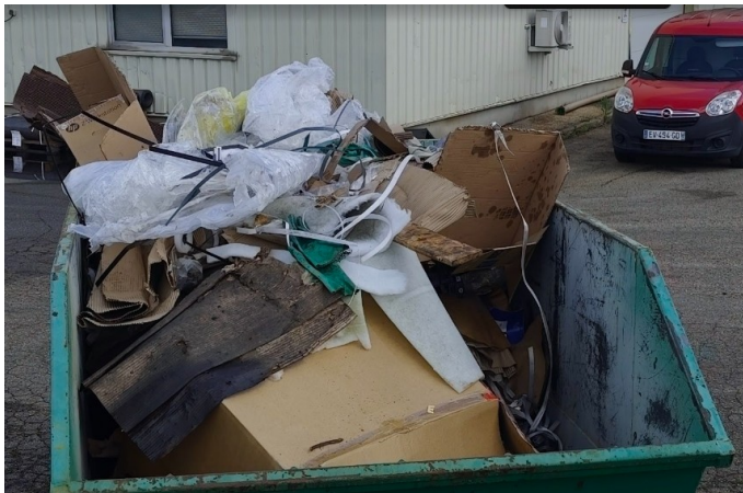
Déchets dangereux (cartons souillés, gants, etc) mélangés avec des déchets non dangereux
