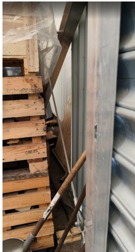
Câble de tension du toit derrière les palettes
