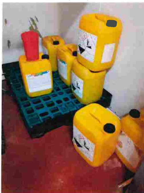
quelques produits dangereux stockés en dehors du dispositif de rétention
