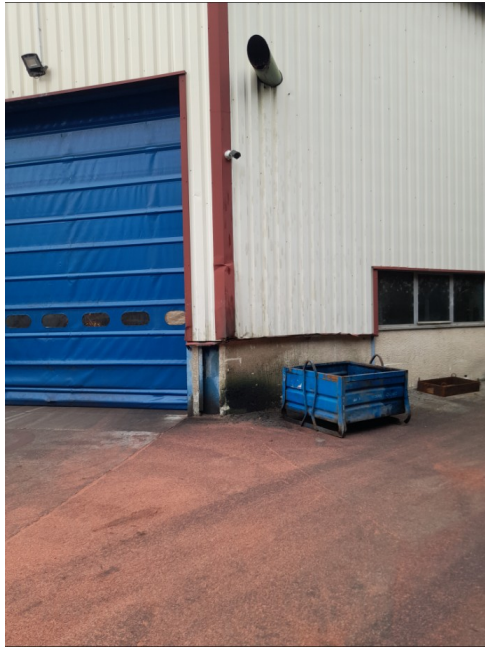
Poussières et copeaux de cuivre disséminés au sol en contre-bas du point de rejet « Sortie E4-1 »
