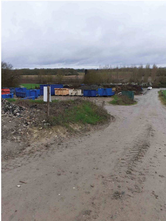
vue générale plateforme de compostage
