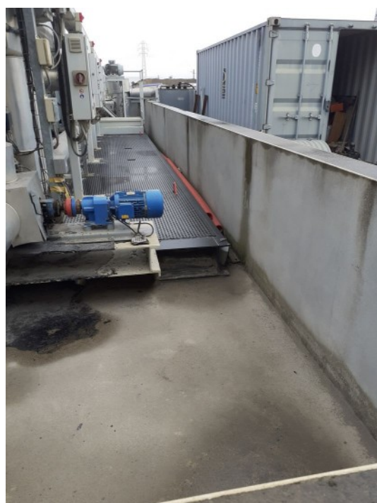
Photo n°4 : tuyaux en plastique présents dans la rétention des cuves de bitume
