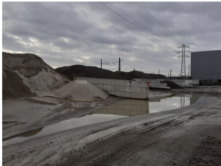
Photo n°2 : tas de granulats dont la hauteur dépasse celle de la paroi de la case en T
