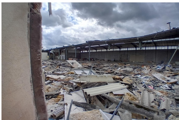
plaques de toitures_20250424_162218
