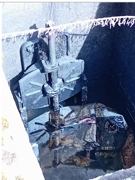
vanne d'isolement_20250424_160821
