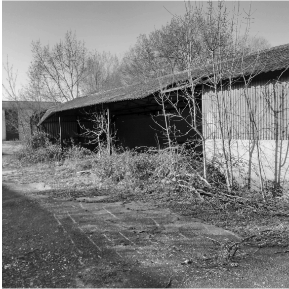
Toiture en amiante-ciment et défaut de solidité
