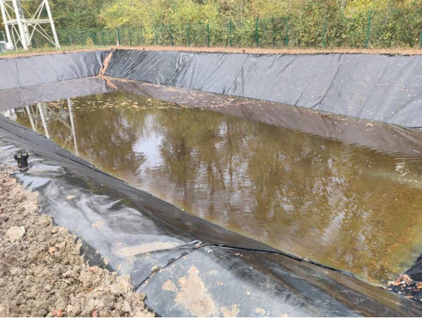
Bassin de rétention des eaux pluviales
