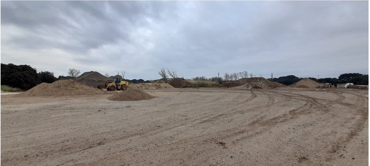
Figure 3: Évacuation de la couche de mâchefer dont le caractère inerte n'avait pas été démontré
