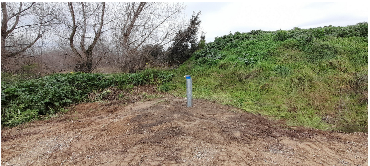
Figure 2: Forage d'un piézomètre en amont hydraulique du site
