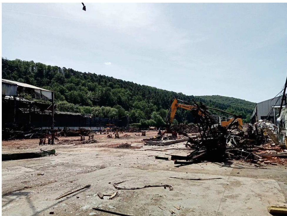
Bâtiment en cours de démolition
