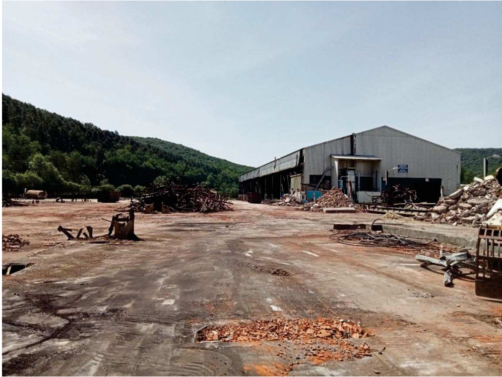
Au fond, ancien bâtiment « expédition » servant de zone de stockage des différents types de déchets triés, avant enlèvement
