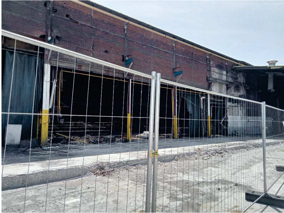
Emplacement de l'ancien four Coïm démantelé
