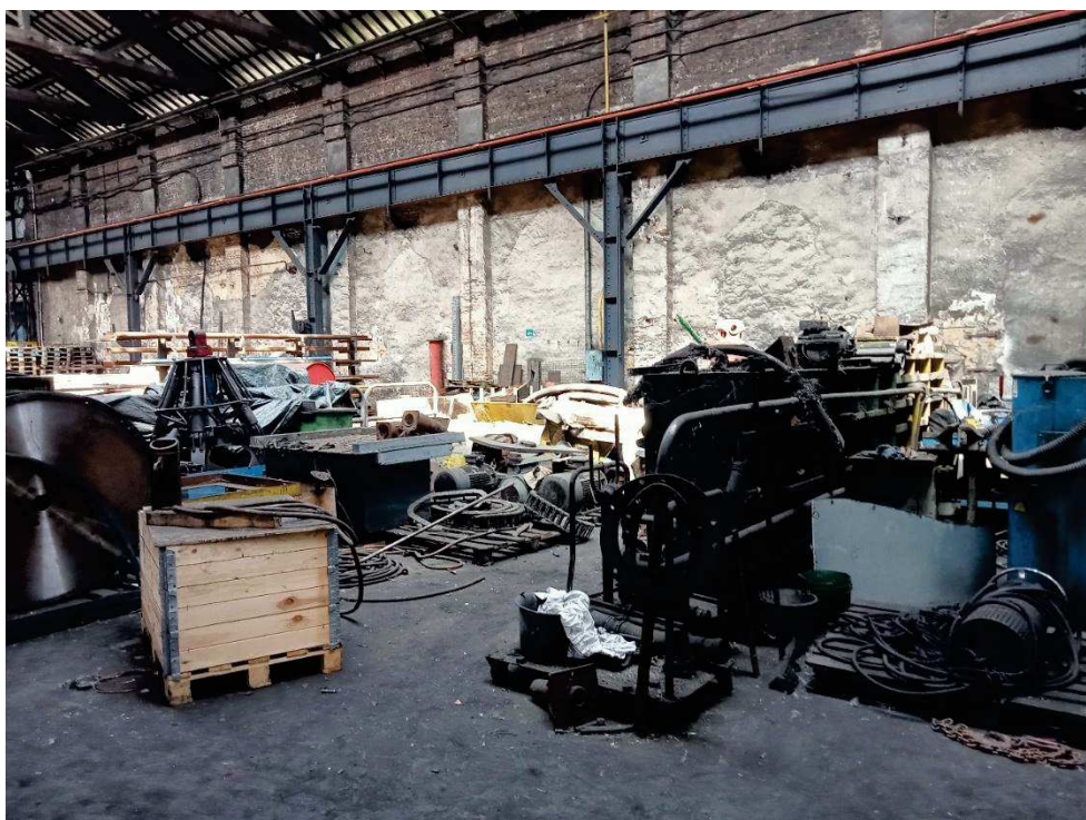
Intérieur du bâtiment
