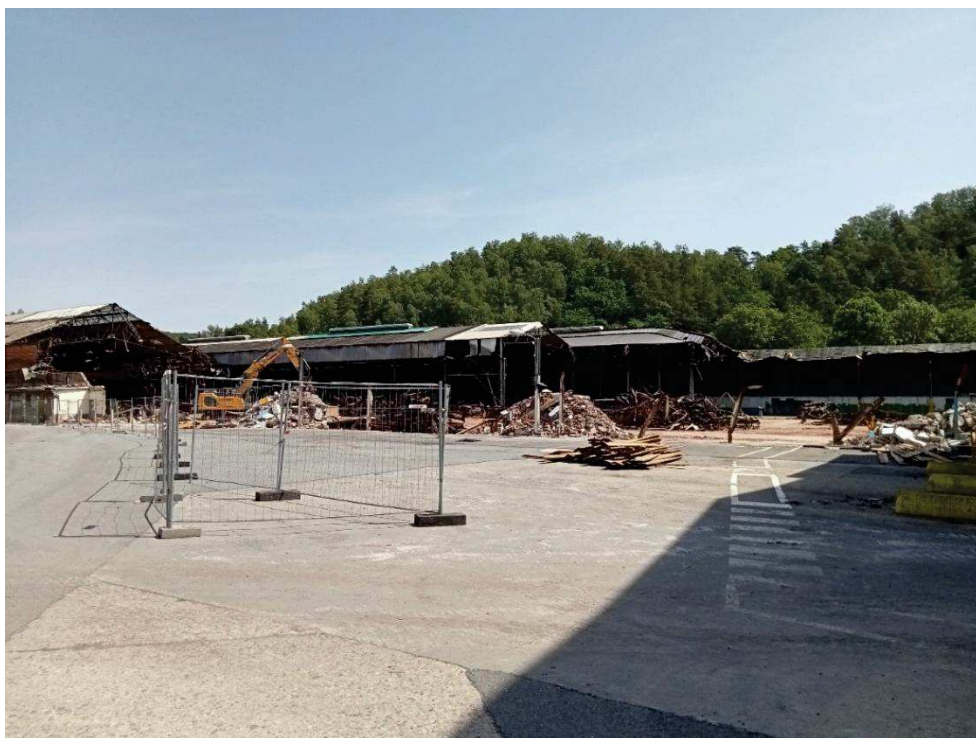
Tuberie en cours de démolition
