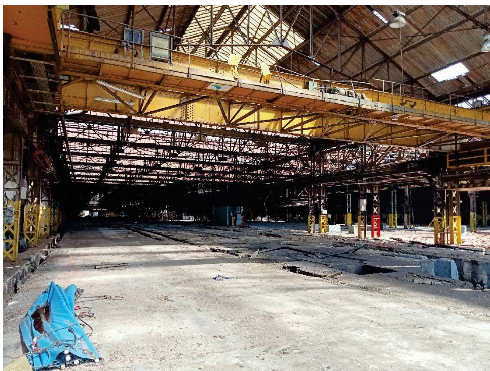
Intérieur du bâtiment tuberie
