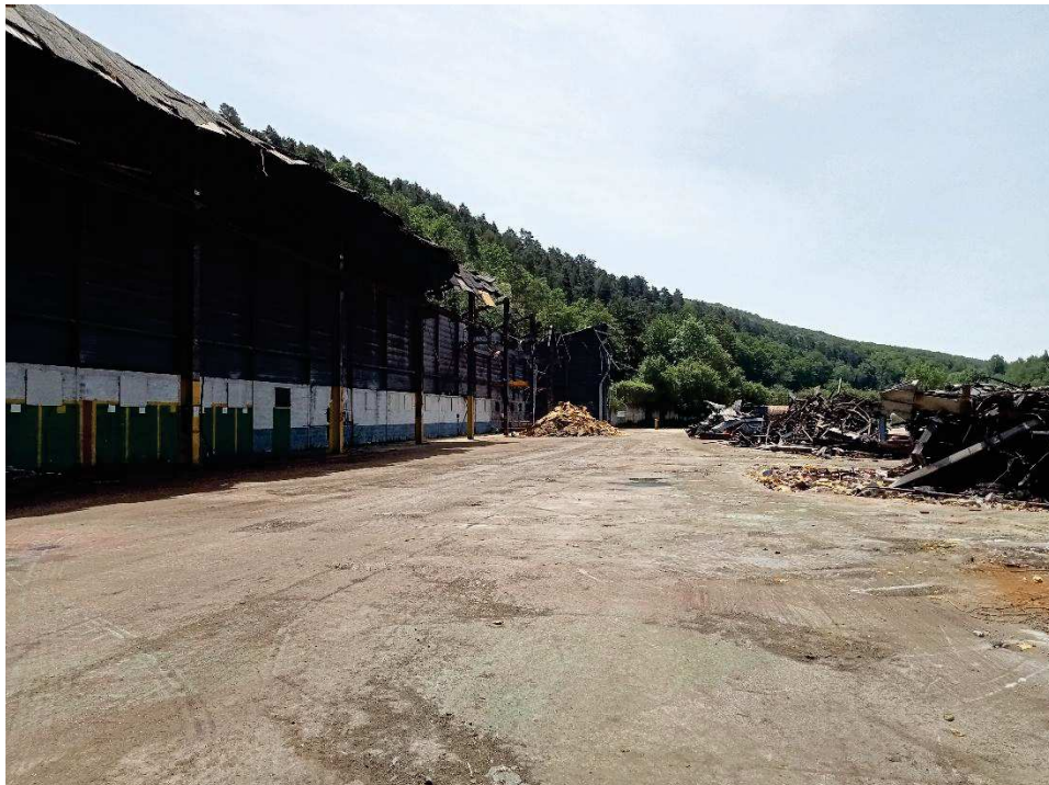
Pan de mur encore en place pour limiter les envols de poussières
