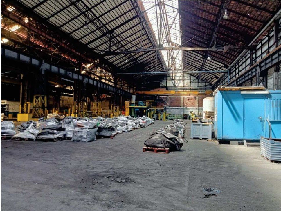
Intérieur du bâtiment : big-bags de déchets de cuivre
