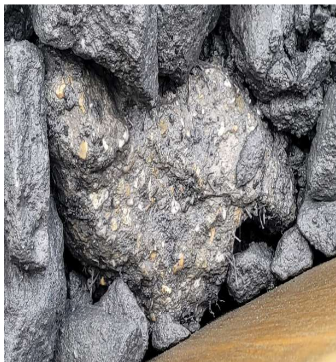
Bloc de béton fibré présent au sein des déchets
