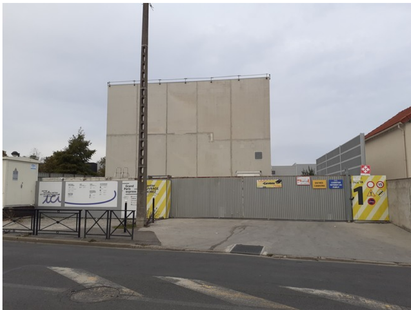
Le bâtiment abritant le puits et les équipements de ventilation et de désenfumage
