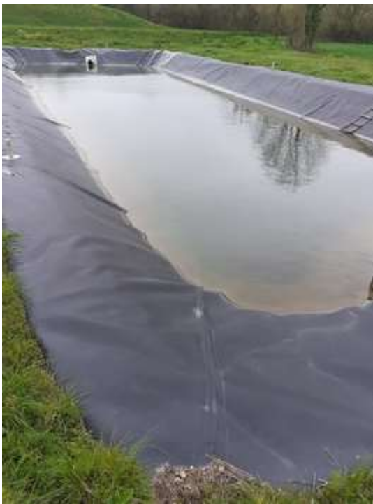
Bassin de récupération des eaux pluviales
