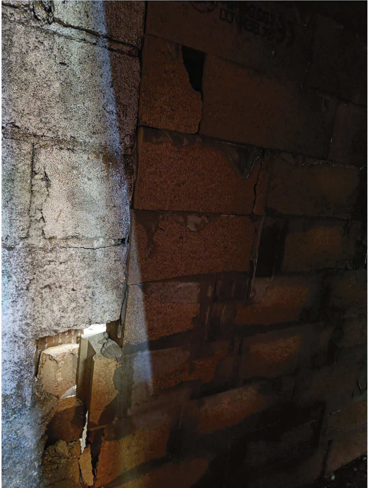
Figure 3 : l'accès bloqué à la zone où les bidons et une cuve de 1000 à 2000 L étaient stockés.
